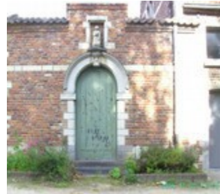
met de toegangspoort tussen het oude schoolgebouw en schoolhuis.
